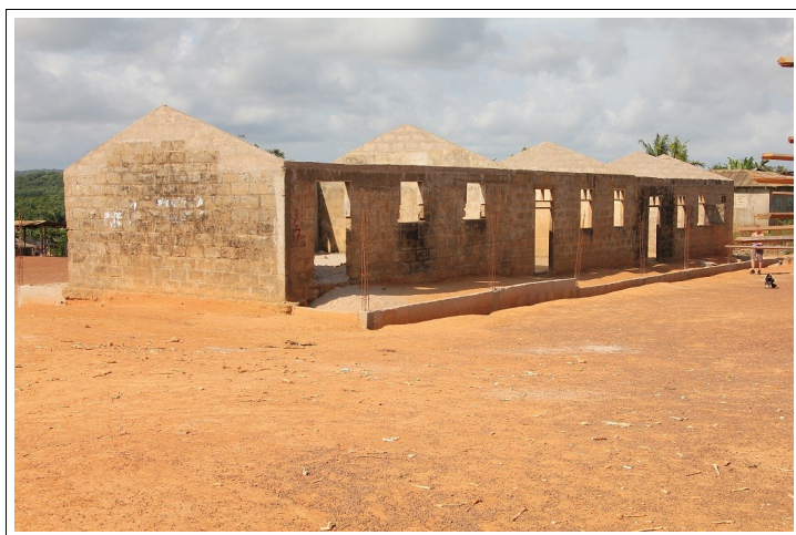
Edificio scolastico da ristrutturare (Primary School)
